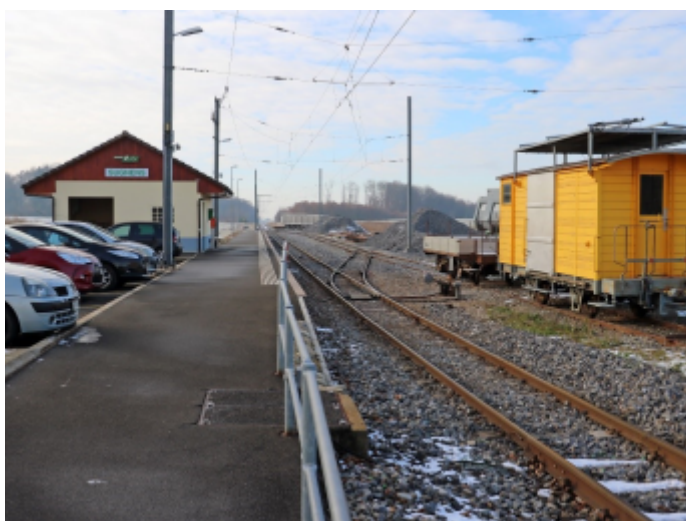
La gare de Sugnens en 2017 (photo Echo du Gros-de-Vaud)
