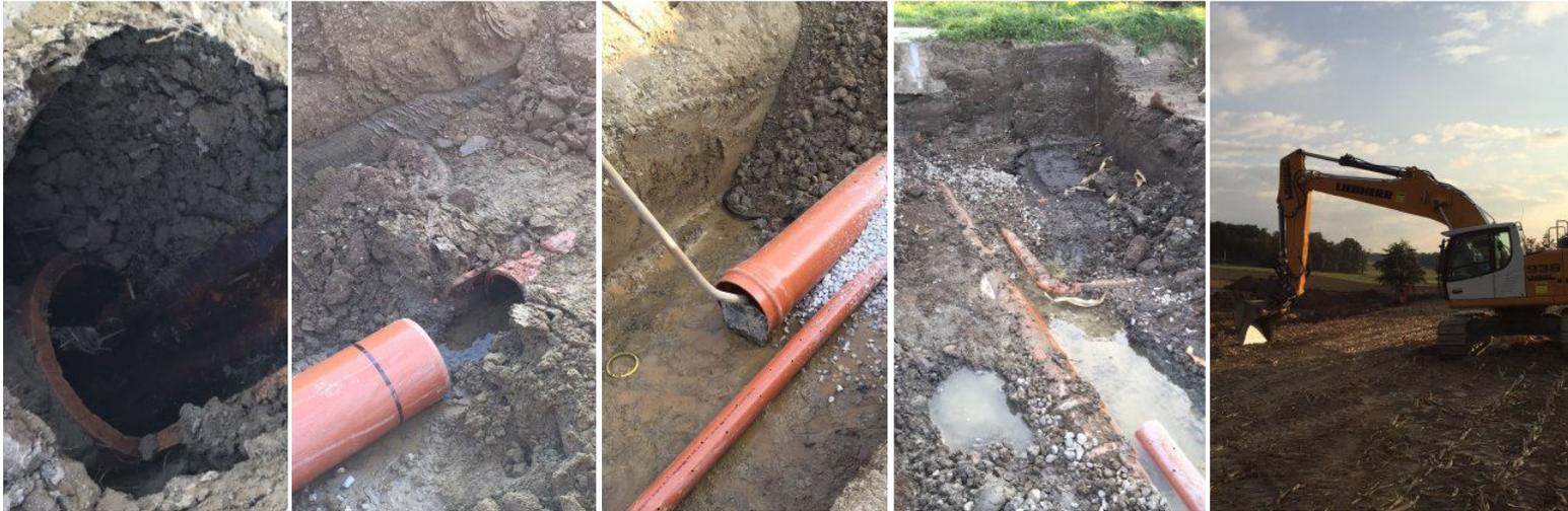
Une fois le nouveau tuyau posé, le remblayage se faisant au fur et à mesure de l'avancement, le nouveau collecteur a été raccordé dans une chambre de visite en aval de la parcelle.
