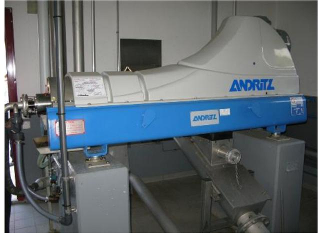
*Centrifugeuse de la step de Bercher (elle n'est utilisée que pour les boues d'épuration)*
